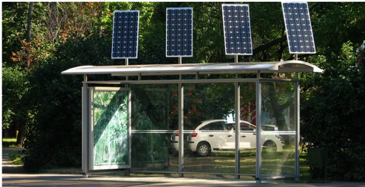
Рисунок 4. Вертикальное расположение солнечных батарей
