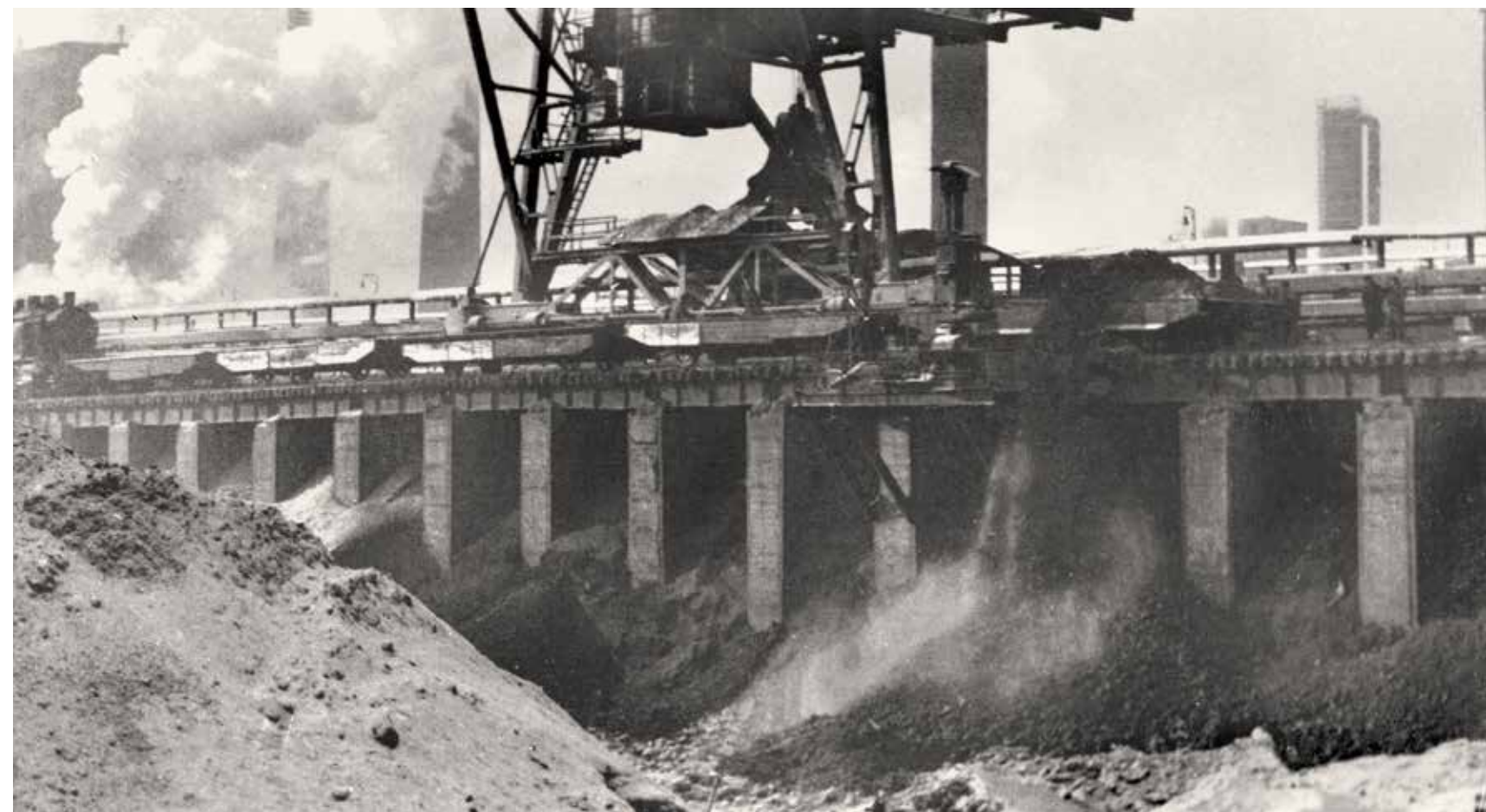
Строительная площадка Днепрогэса СССР. До 1932 г. В.Н. Образцов был членом технического совета Днепростроя, что позволило ему проверить свои научные идеи во время постройки станции
