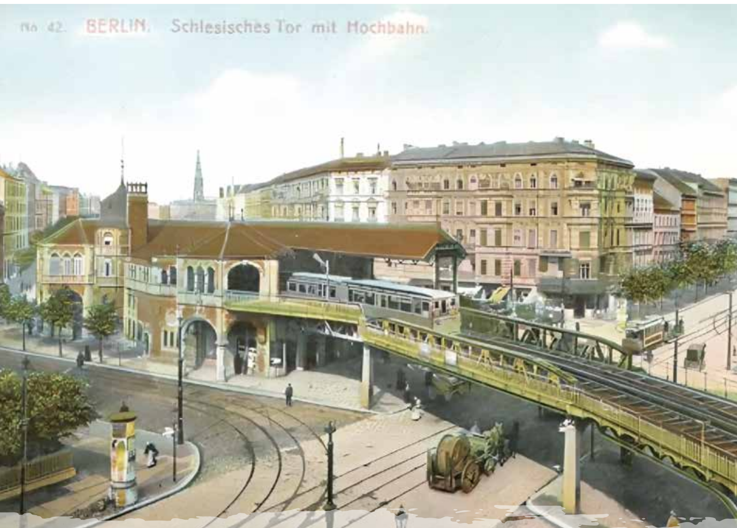
Эстакады в Берлине: металлическая эстакада близ Силезских ворот 1910 г.
