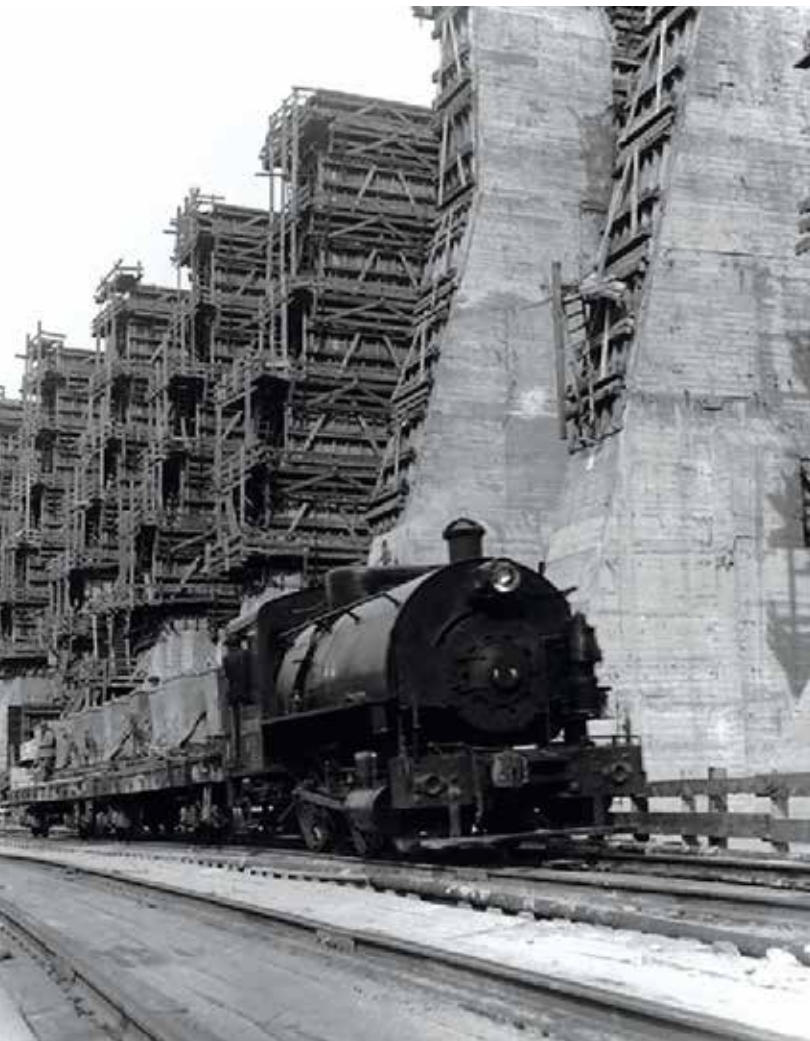
Строительство Днепрогэса, 1930 г.
