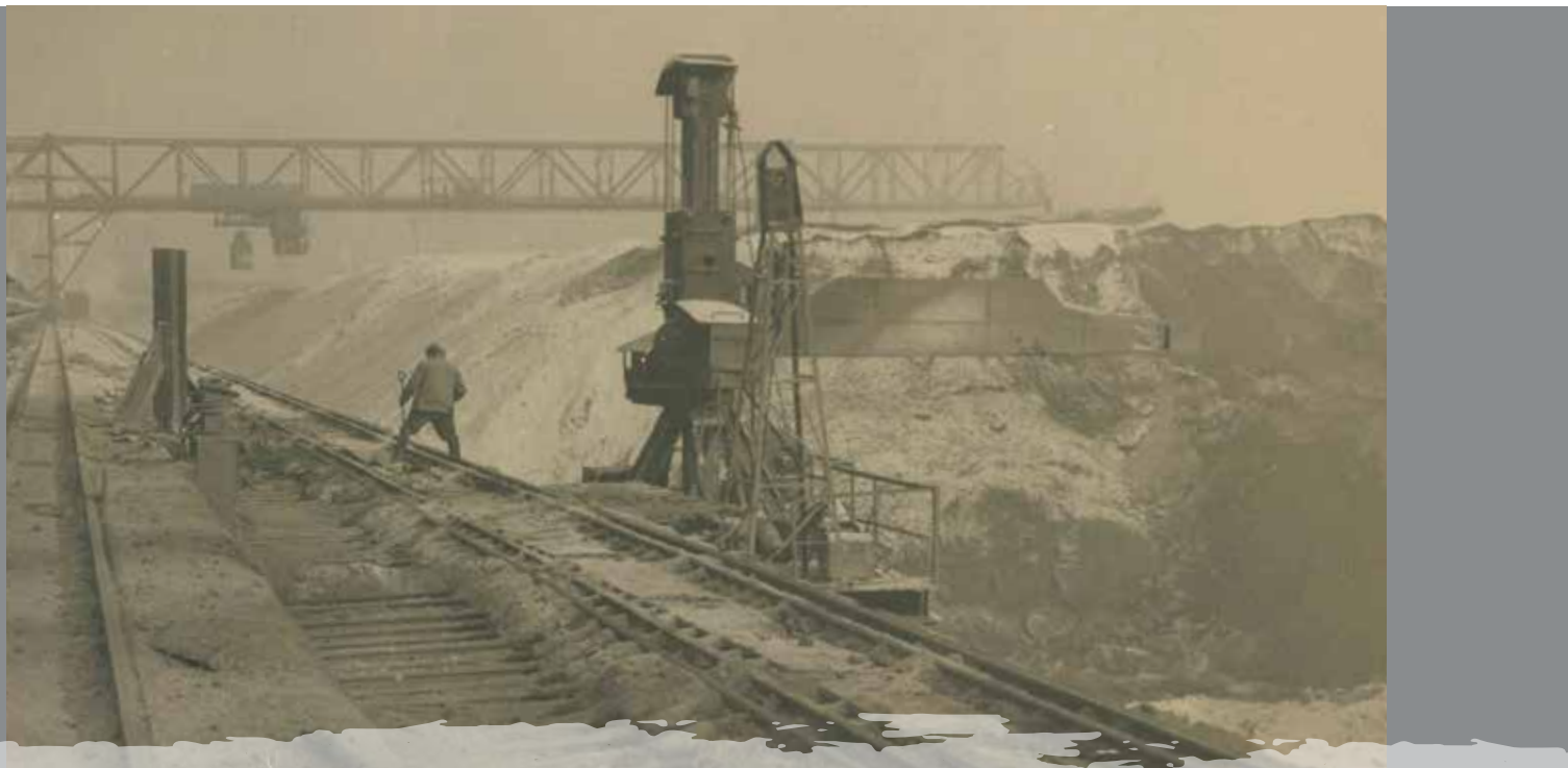
«Путиловец» - российский паровой экскаватор железнодорожного типа. В 1906-1916 гг. он применялся при постройке железных дорог - Северо-Донецкой, Сибирской, Казано-Екатеринбургской, Петербург-Орёл, Мурманской
