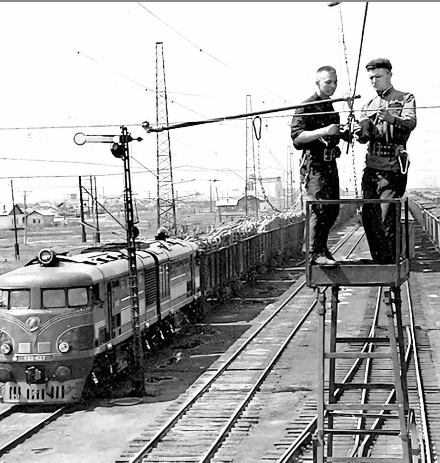
Электромонтеры осуществляют ремонт контактной сети. СССР
