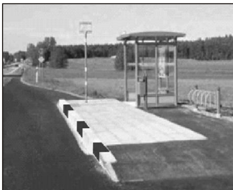
Рисунок 48 – Пример обустройства остановочного пункта пандусом
