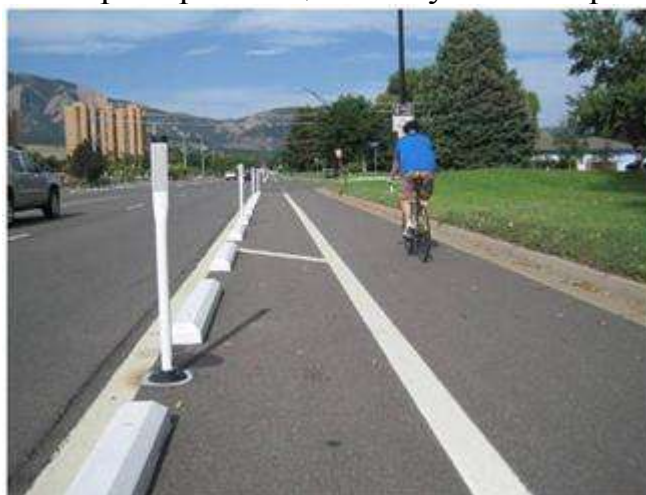
Рисунок 3.12. Пример разделительной полосы переносными конструкциями
