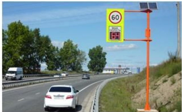
Рисунок 9.1 - Установка дорожных знаков с обратной связью
