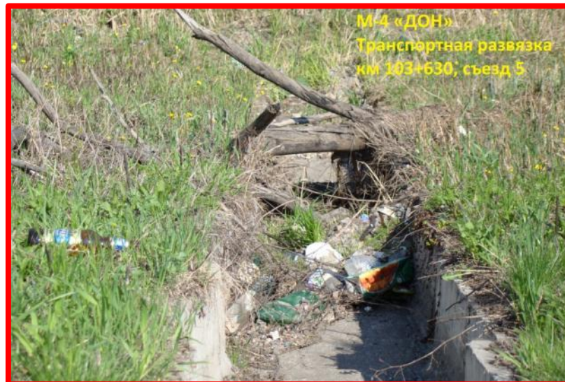
Не очищенная от мусора система водоотвода (водоотводные, прикромочные лотки, быстроточки, нагорные канавы и т.д.)
