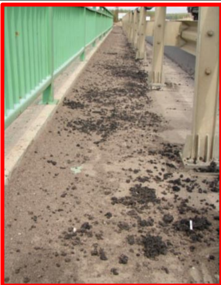
Не очищенная от мусора система водоотвода (водоотводные лотки, гасители и т.д.)
