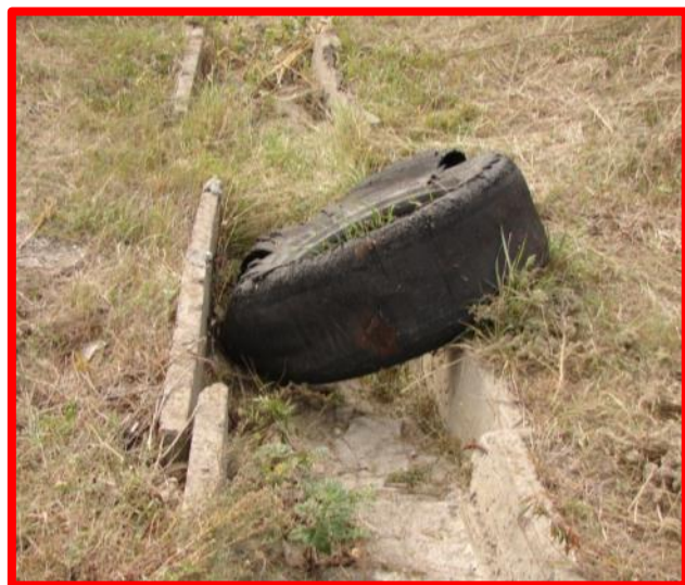
Не очищенная от мусора система водоотвода (водоотводные лотки, гасители и т.д.)
