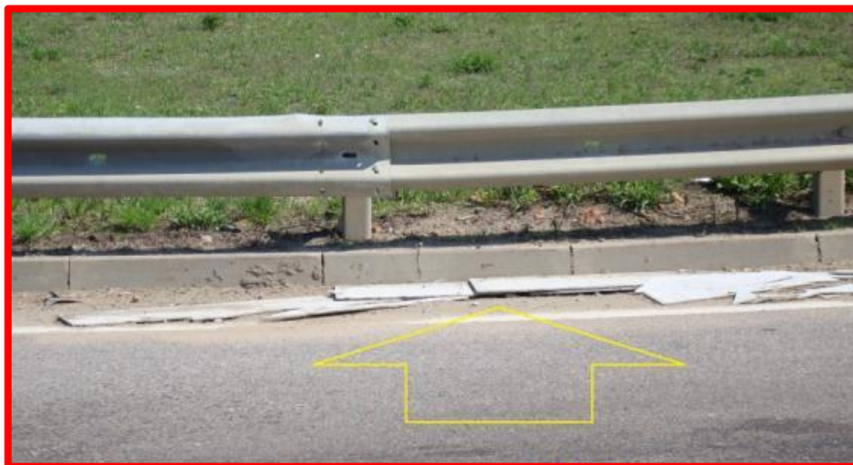
Наличие мусора на осевых полосах и полосах безопасности обозначенных линиями горизонтальной дорожной разметки
