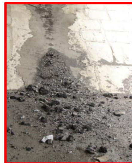
Не очищенная от мусора система водоотвода (водоотводные лотки, гасители и т.д.)
