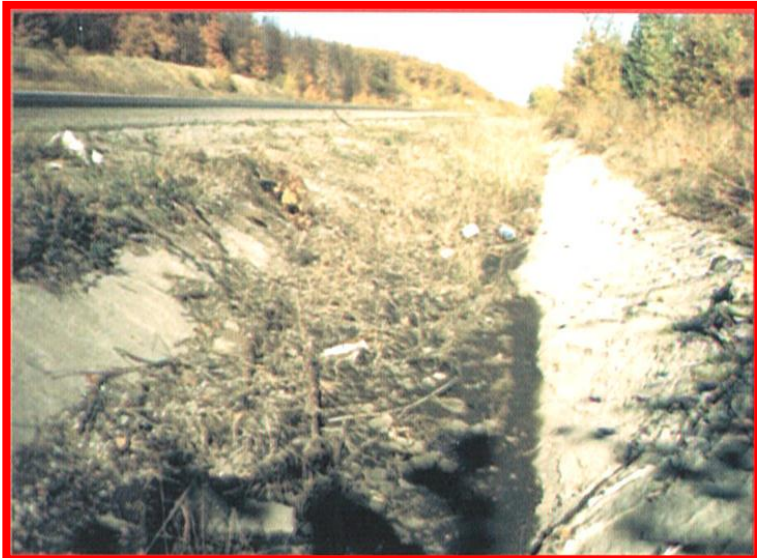
Не очищенная от мусора система водоотвода (водоотводные, прикромочные лотки, быстроточки, нагорные канавы и т.д.)
