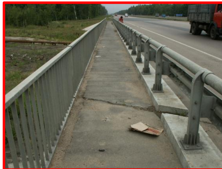
Не очищенная от мусора система водоотвода (водоотводные лотки, гасители и т.д.)
