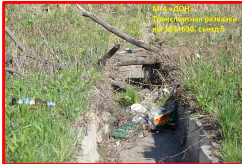
Не очищенная от мусора система водоотвода (водоотводные, прикромочные лотки, быстротки, нагорные канавы и т.д.)
