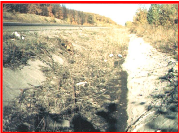
Не очищенная от мусора система водоотвода (водоотводные, прикромочные лотки, быстротки, нагорные канавы и т.д.)
