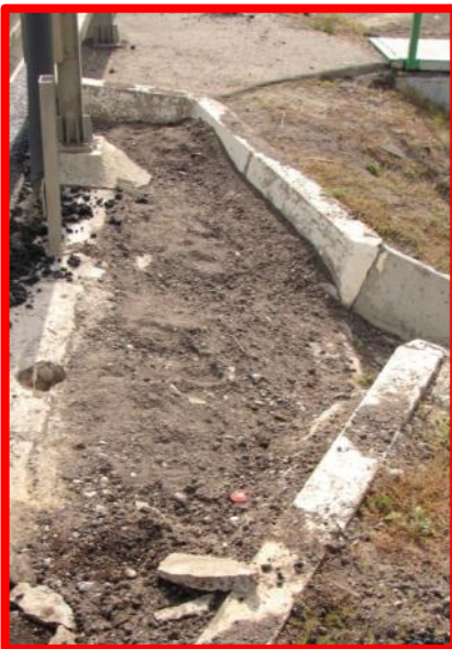
Не очищенная от мусора система водоотвода (водоотводные лотки, гасители и т.д.)
